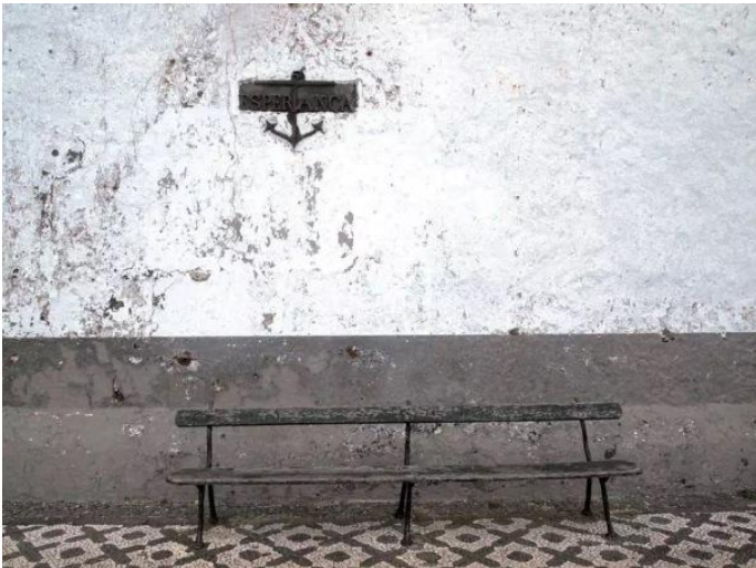
不刷底漆可能造成的漆面剥落
